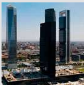
Torre Caleido (Madrid)
